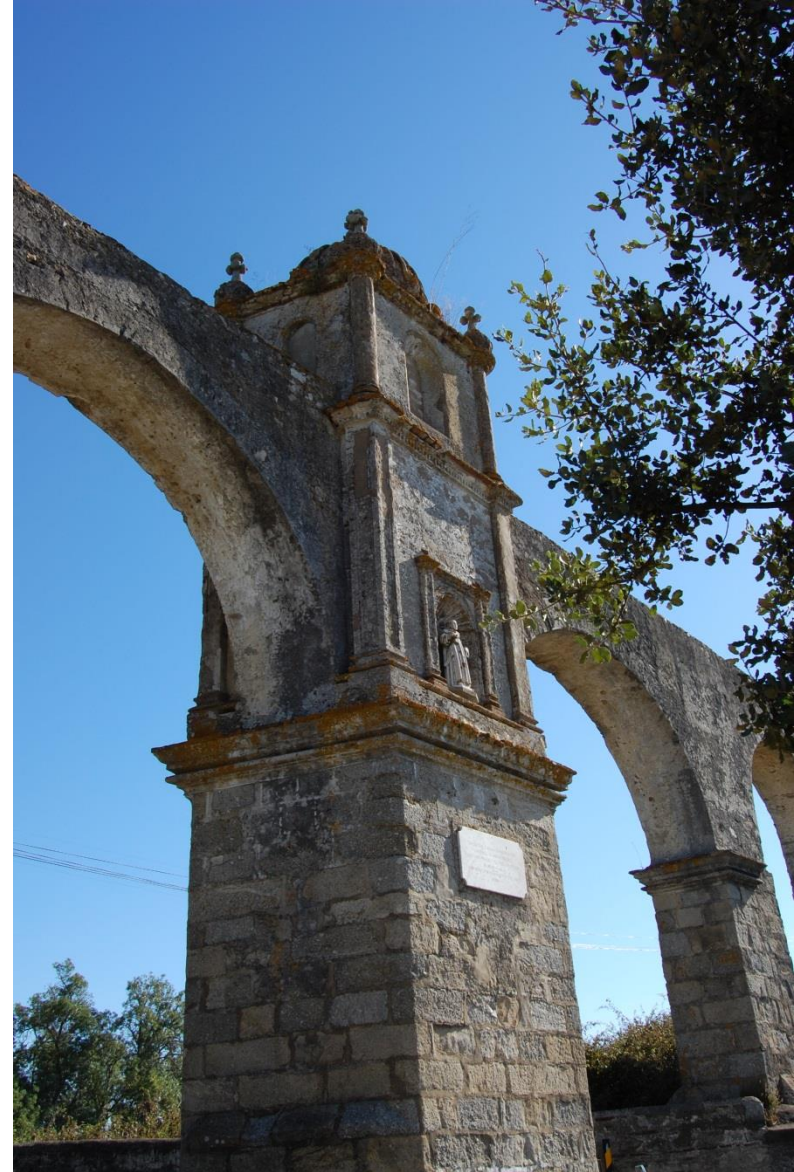
Aqueduto da Água de Prata Monumento Nacional
